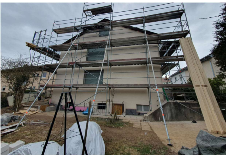
Das noch ungedämmte Gebäude mit bereits demontierten Fenstern. Foto: Darius Heller / Zukunft Altbau
